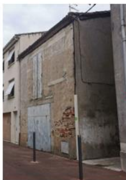
Dépendance au 32 rue Gouget à démolir
