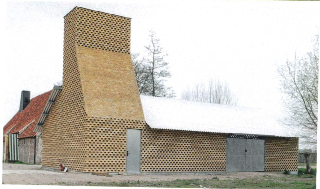
↑ Reconversion d'une ancienne ferme - Bat.1 (Brique pleine, toiture zinc, linteau béton)- Zoom architecte/BAST ↑ Reconversion d'une ancienne ferme - Bat.2 (Brique cuite, toiture tôle ondulée, porte métallique)- Zoom architecte/BAST
